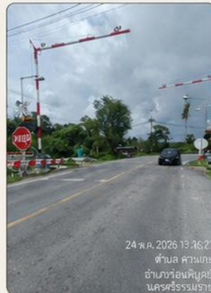
1 จุดตัดป้ายเตยเขน ม.4 ต.ควนชุม ไม่มีไม้กั้น ไม่มีกล้อง CCTV
